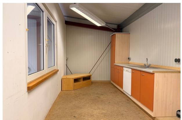
Aufenthaltsraum, mit Küche
