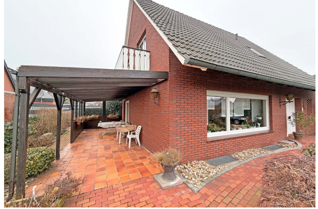
Seitenansicht mit Überdachung
